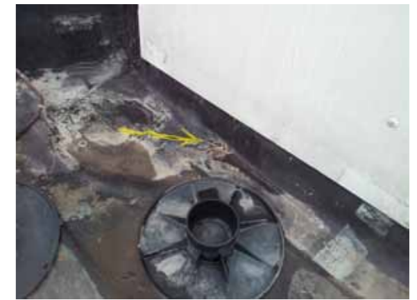
Meerdere inwateringspunten zijn aangetroffen
