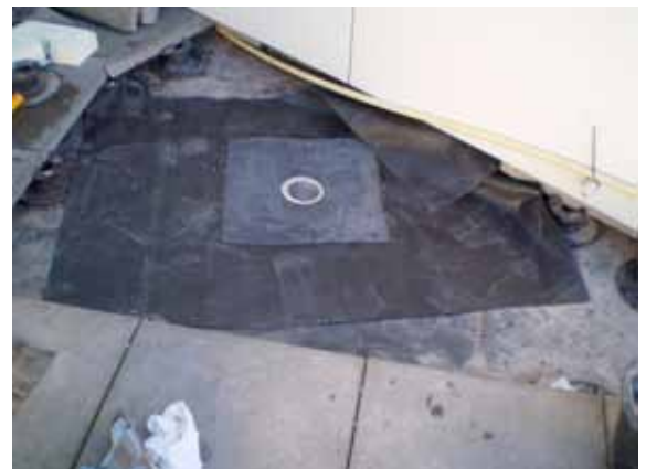
Gereed om af te werken op de bestaande dakbedekking
