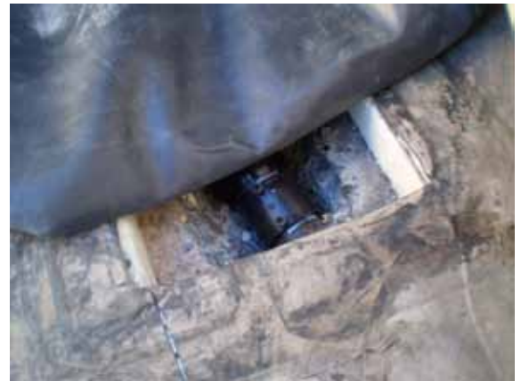
De afvoer voorzien van plakstukken en aangesloten op de afvoerleiding
