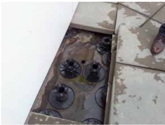
Zeer geringe diameter hemelwaterafvoer
