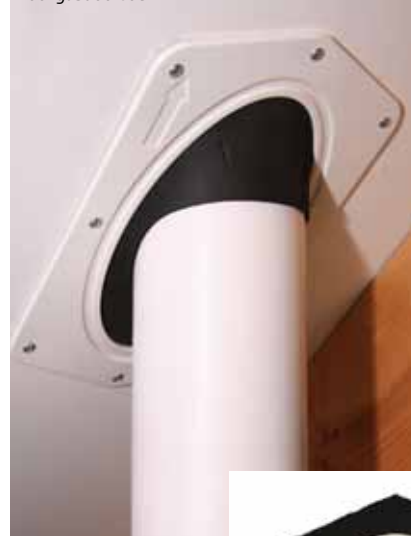
Luchtdichte manchet rond rookgasdoorvoer.
