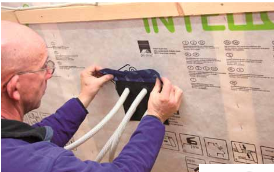
Zelfklevende manchet rond kabeldoorvoer
