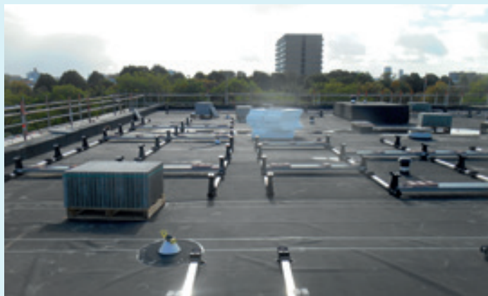
Foto 6: Veilig uitvoeren van onderhoud aan de dakbedekking is in de onveilige zone niet meer mogelijk.
