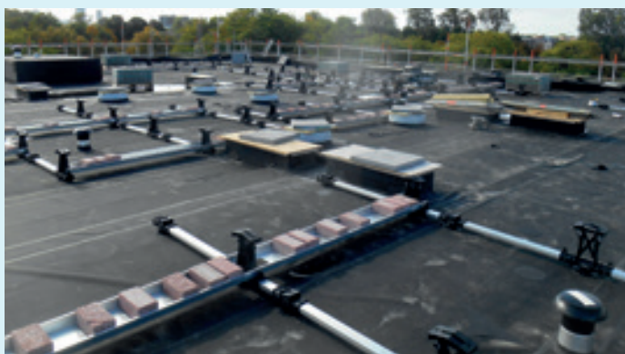
Foto 4: Na aanbrengen EPDM dakbedekking werden PV-panelen op het dak geplaatst.
