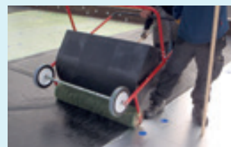
Foto 7 en 8: De lijm wordt in een emmer geroerd en daarna in het reservoir gegoten. De lijm wordt egaal over het oppervlak verdeeld.
