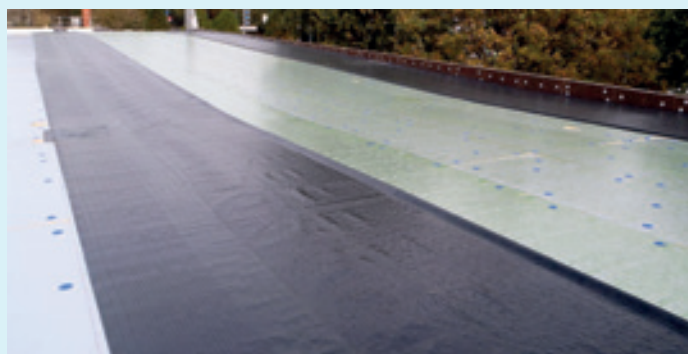
Foto 9: De EPDM membranen worden op de isolatie gekleefd.
