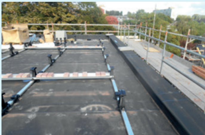
Foto 5: PV-panelen aangebracht tot circa 1 meter vanaf de dakrand.
