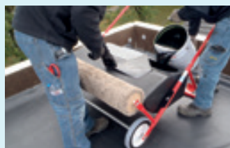
Foto 7 en 8: De lijm wordt in een emmer geroerd en daarna in het reservoir gegoten. De lijm wordt egaal over het oppervlak verdeeld.
